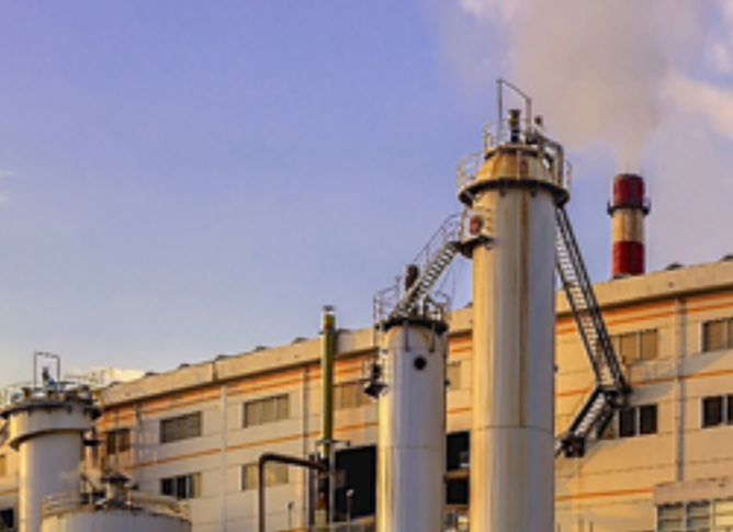
应用物联网技术的高速生活纸机控制室
